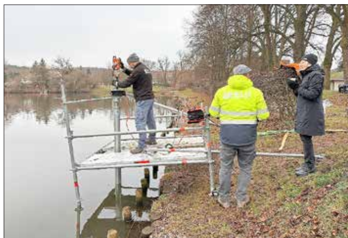
Erprobung der Schraubfundamente am Vorwerksteich in Allstedt (rechts im Bild: Architektin Brigitte Häntschi)
