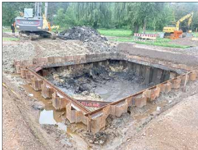
Baugrube für das Schwallbecken. Der Baugrund nur Morast.
