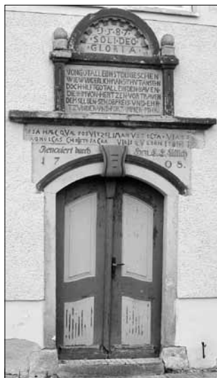
Portal des Gutshauses ehemals Lüttich in Niederröblingen
