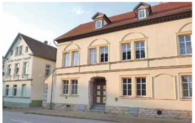
„Thälmannhaus“, Breite Straße 20 - Fassade 2010 neu
