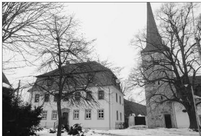
Das neu verputzte Pfarrhaus und die Kirche Niederröblingen
