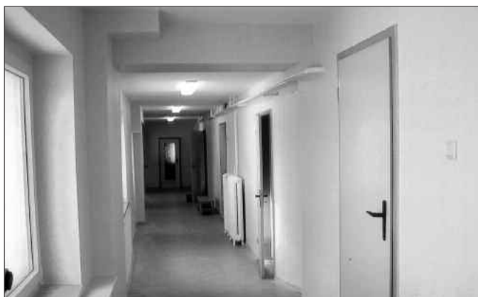
Nach der Renovierung
