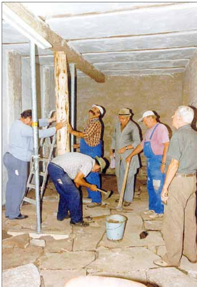
Die neue Deckenstütze wird aufgestellt v. l. n. r. Werner Schlennstedt, Hans Tetzl, Fritz Goldschmidt, Hans Ehrh, Erich Brödel und Ullrich Hollstein
