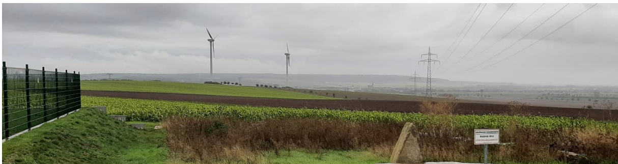
Abbildung 9: Blick vom Umspannwerk Richtung Südosten auf Allstedt
